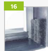
Windstoper (uszczelnienie likwidujące ewentualne przedmuchy w części progowej)
