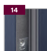
Uszczelka pęczniąca [drzwi PPOŻ]
